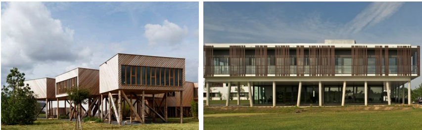
Bureaux sur pilotis, en terrain sensible
