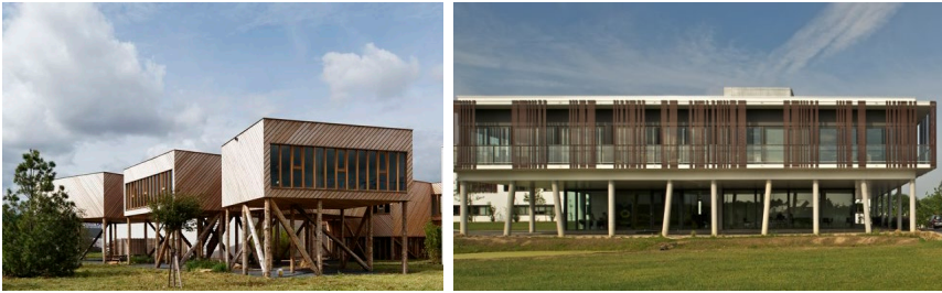
Bureaux sur pilotis, en terrain sensible
