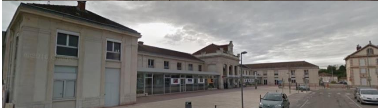
Gare Chalon-s/Saône : Bureaux et immeubles mixtes bureaux/logements
