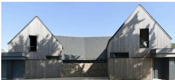
Exemple de maisons jumelles, SABA Architectes, Perros-Guirrec
