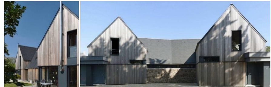
Exemple de maisons jumelles, SABA Architectes, Perros-Guirec
