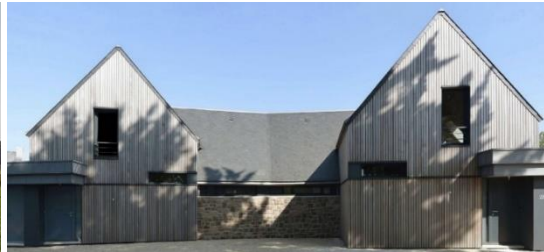
Exemple de maisons jumelles SABA Architectes, Perros-Guirrec
