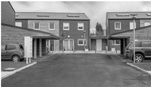
Exemple de cour commune comprenant du stationnement Maisons groupées à ossature bois, région de Nantes Belenfant et Daubas Architectes 2013
