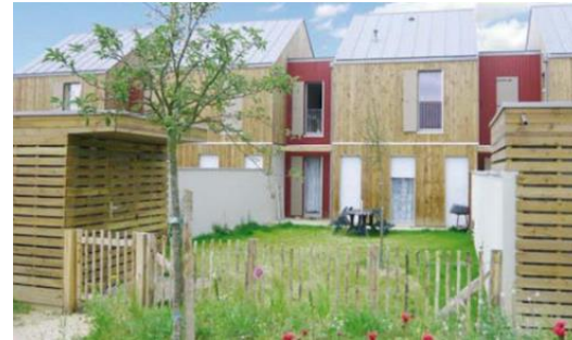
Façade de logements individuelles mitoyens en bois
