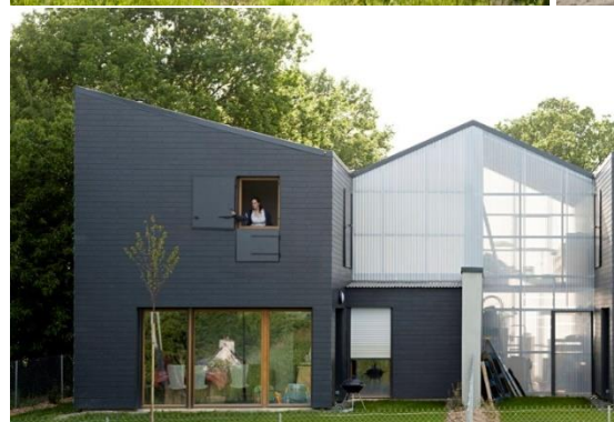
Vézin-le-Coquet, Alexandre Fave et Laurent Lagadec architectes
