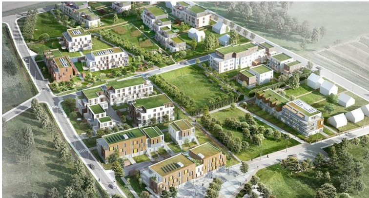
ZAC des meuniers, Bessancourt, (95) – Richez et associés
