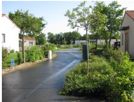
Voie tertiaire-voie partagée (voitures, piétons, vélos) à sens unique Treize-Septiers (85) - La Papinière
