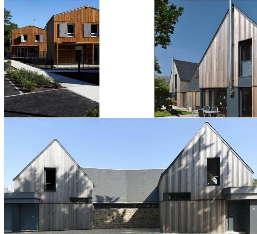
Exemple de maisons jumelles, SABA Architectes, Perros-Guirrec
