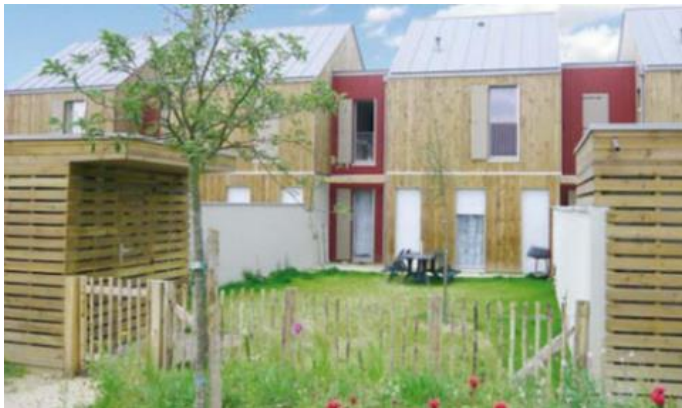
Façade de logements individuelles mitoyens en bois
